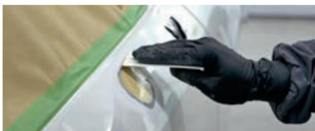
**SCHRITT 3:** Reinigen und tragen Sie ggf. einen Spachtel auf. Verwenden Sie z. B. **779R Multifunktions-Spachtel**.
